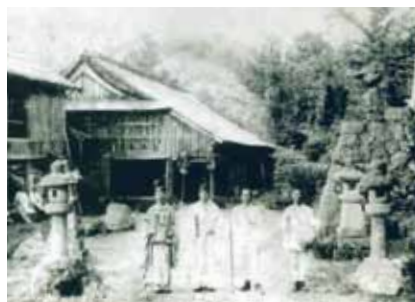
かつての玄海折橋所は、礎石のみが現存する
